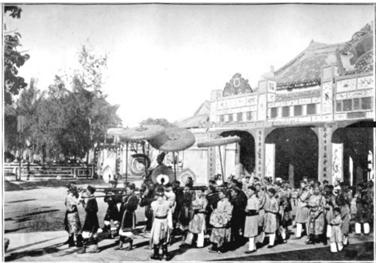
Planche L. — Le Quarantenaire de S. M. Khải-Định : « Un premier portique lumineux, formé de cinq passages voûtés ... ».
